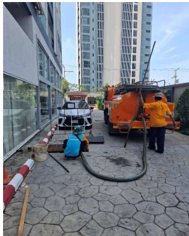
ภาพที่ 7 แสดงการสูบน้ำจากบ่อน้ำบาดาล
