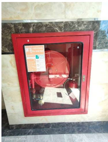
ภาพที่ 35 แสดงตู้ดับเพลิง (Fire Hose Cabinet)
